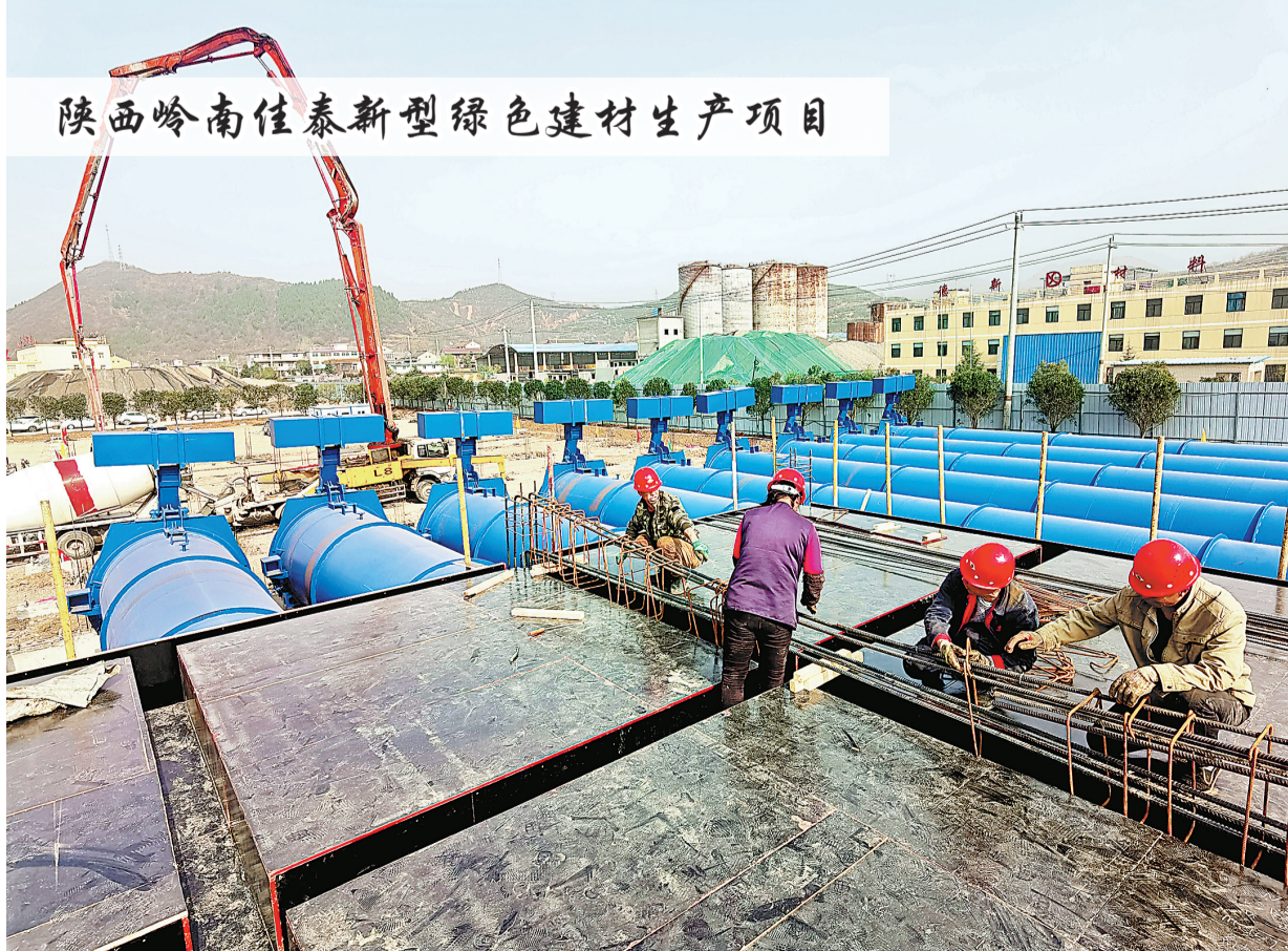
位于商州区中小企业创业园的陕西岭南佳泰新型绿色建材生产项目，占地80亩。项目于今年1月动工建设，一期项目建成后，可实现年产值5亿元，年利税6000万元。该项目作为陕西建筑智能制造产业新基地之一，将有力推动商洛建筑工业化进程。图为3月15日工人正在紧张施工。（本报记者 杨鑫 摄）
