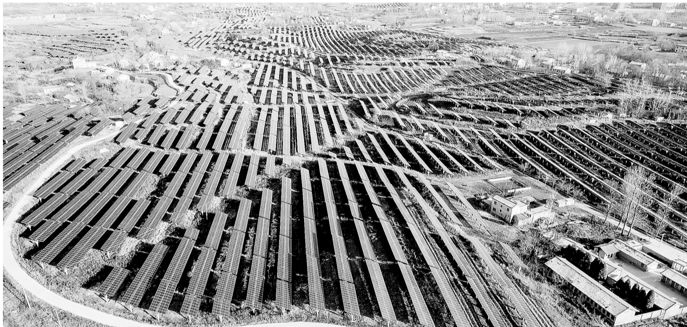
洛南县100兆瓦光伏农业与观光旅游项目位于洛南县四皓街道、永丰镇境内的梁塬,占地2800亩,总投资8亿元,是2021年省级重点项目,也是陕南地区最大的光伏农业与观光旅游综合利用示范项目,年发电量1.2亿度,产值0.75亿元。该项目的建成投产,对洛南县能源结构调整以及巩固拓展脱贫攻坚成果、助推乡村振兴等具有积极意义,已经成为展现在洛州大地上一幅“政、企、村、户”四方共赢,一、二、三产融合发展的美丽画卷。
