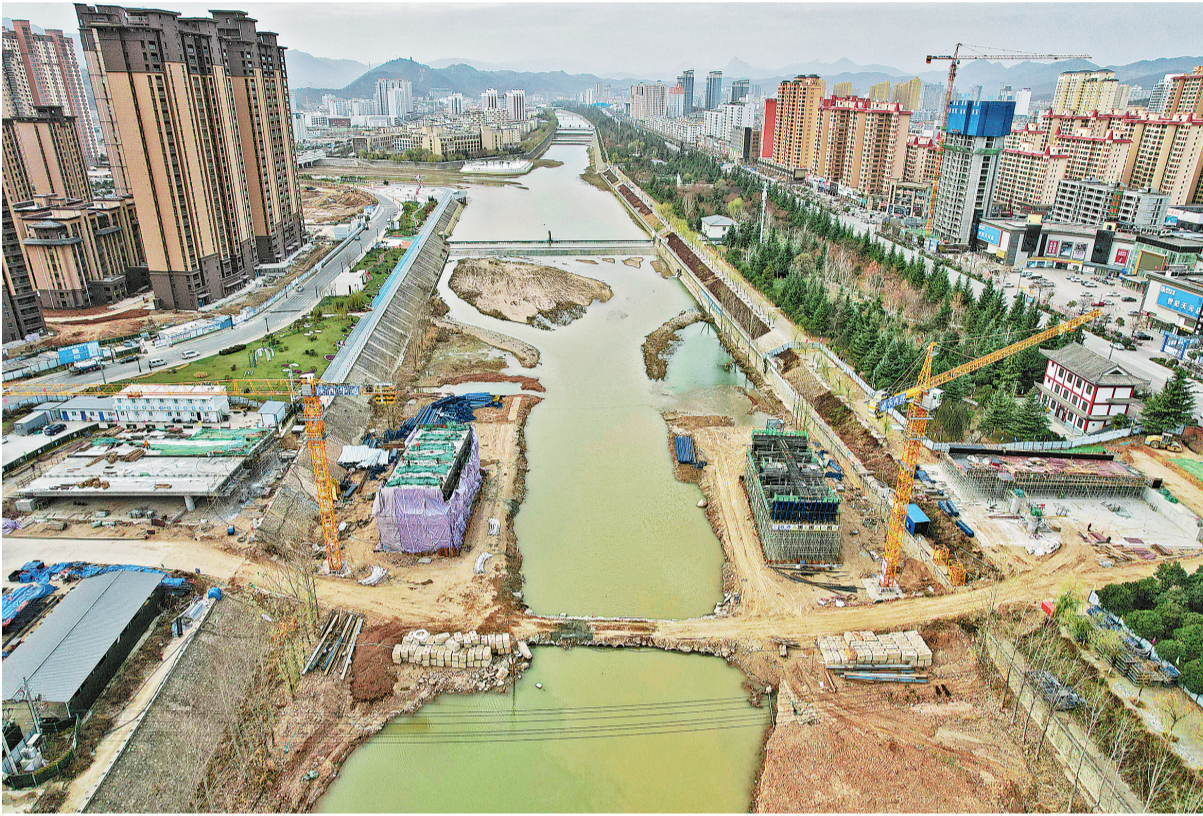
12月13日,商州区刘湾大桥项目桥墩工程正在紧张施工。据了解,刘湾大桥建成后,桥长207.08米,宽26米,有非机动车道和机动车道,使丹江两岸群众出行更加便捷。(本报记者 杨鑫 摄)
