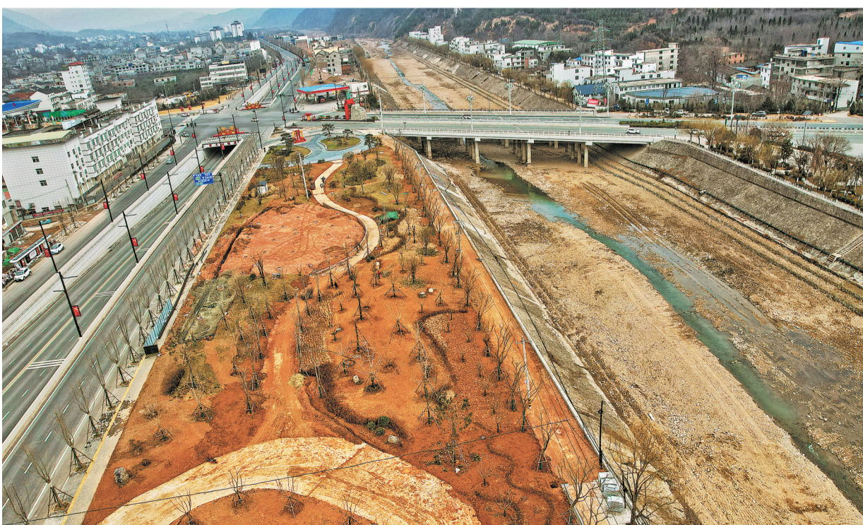
南秦河生态治理项目西起南秦水库，东至两河口，全长约10公里，滨水空间可用建设用地约60公顷。按照“一心两带三区”定位，划分为静谧森林、湿地绿心、花园漫步三个生态主题区。建成后，将有效提升和改善中心城区水生态系统，让市民切身感受“回归自然、可观可赏、可游可憩”的生态绿野，为打造“中国康养之都”提供生态支撑。图为2月16日，南秦河生态治理项目施工现场。（本报记者 杨鑫 摄）
