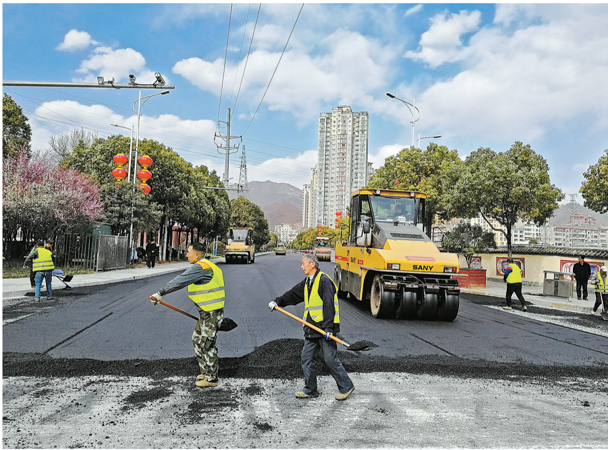
道路“白改黑” 旧貌换新颜
