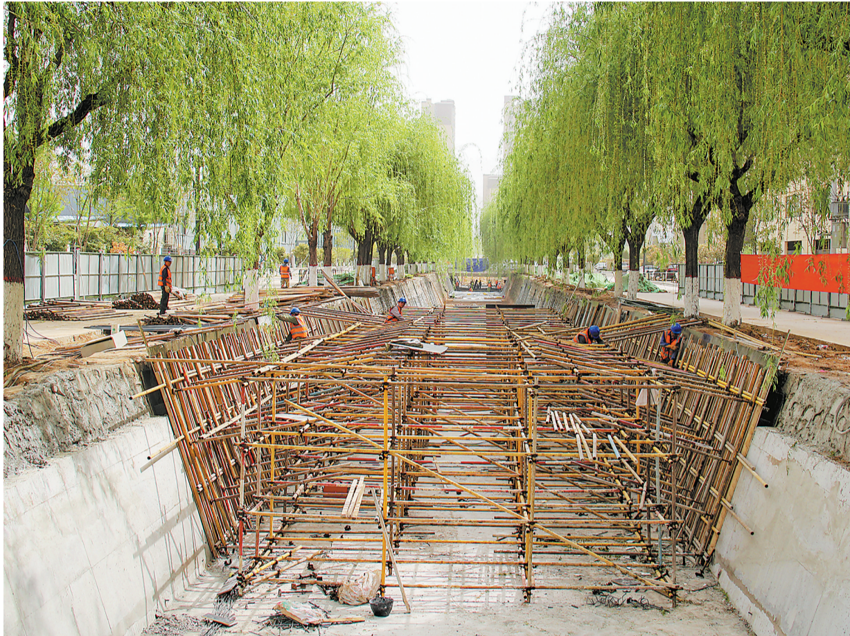
马莲峪水生态修复项目是中心城区“一渠两河七沟峪”水生态修复工程之一,全长1.7公里,3月初启动施工,计划5月底完成,通过引南秦河水入马莲河、河道清淤疏浚、修建拦水坝等,让马莲峪变得鸟语花香、人水和谐。(本报记者 余婷 摄)
