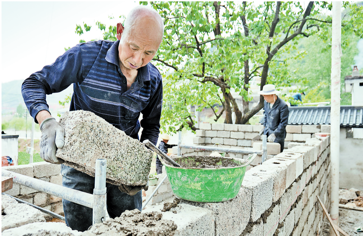
4月17日,山阳县银花镇银花社区群众正在改厕改房施工中。银花社区计划改厕140多个,改造土坯房280多户,拓宽硬化通组路1条,修建公厕、围墙、护栏、柴棚等,进一步改造提升农村人居环境。(本报通讯员 汪涛 摄)
