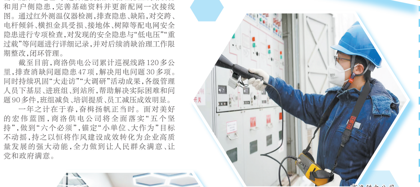
商洛供电公司工作人员利用超声波检测仪检查环网柜电缆接头是否有高压放电现象,排查设备隐患。
