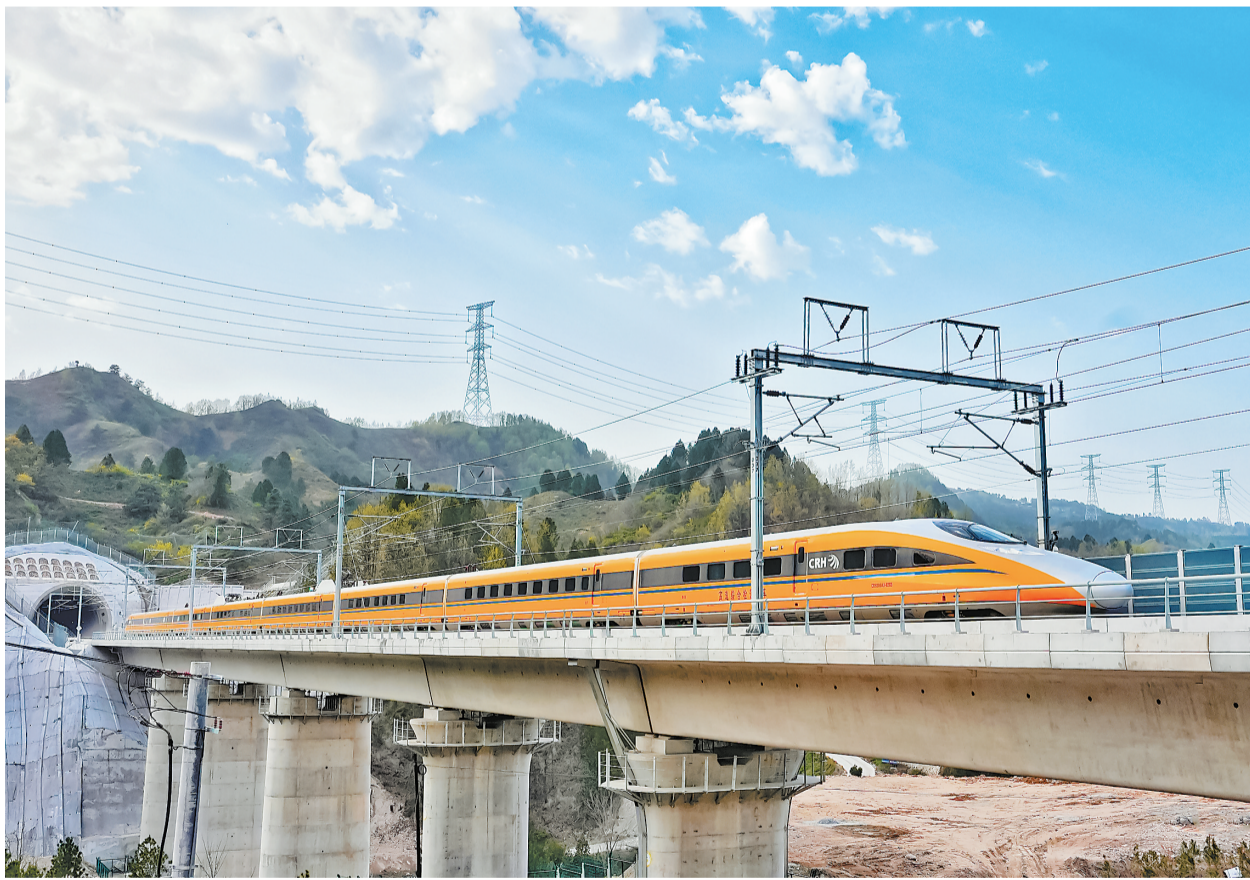
4月4日，西十高铁联调联试进入全面综合检测关键阶段，CRH380AJ型高速综合检测列车对线路开展多系统、全要素检测，精准校验线路各项技术指标，为后续试运行及正式开通运营夯实坚实基础。（本报通讯员 闫青竹 摄）
