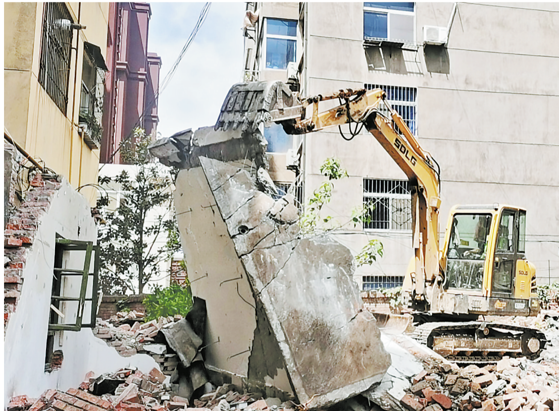
4月21日,商州区域综合执法大队对煤炭公司家属院内的违法建筑进行拆除。据了解,该小区是比较老旧小区,院内乱搭乱建十分严重,影响了正常住户的居住环境及采光,本次拆除工作对小区环境有了很大改善,为住户提供了良好的居住条件。
