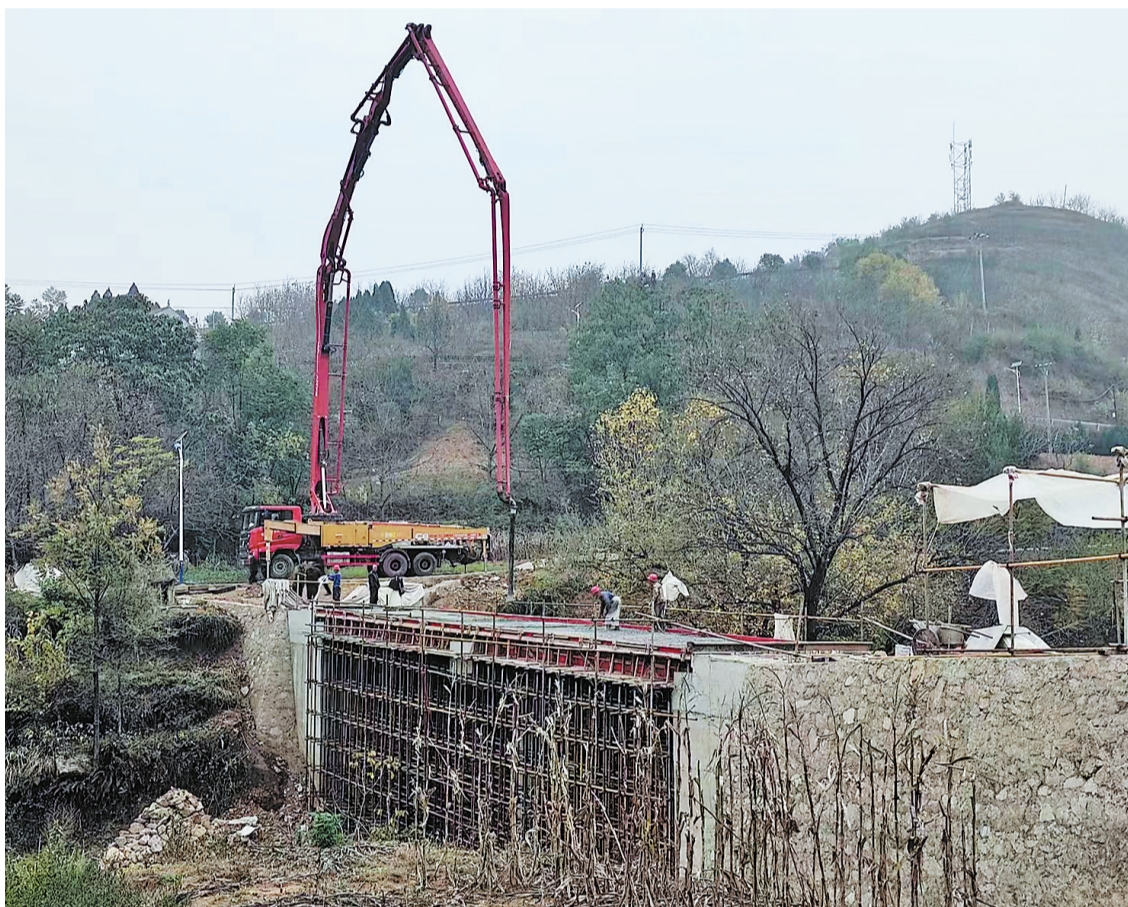
11月5日,随着施工水泥罐车最后一罐水泥的浇筑,丹凤县棣花镇陈家沟村产业桥顺利竣工。这是省委办驻村工作队争取项目资金80万元,为该村建设的一座宽4.6米、跨河60米的水泥平板桥,解决了两岸300多户群众出行不便的难题。(本报通讯员 张文彬 摄)
