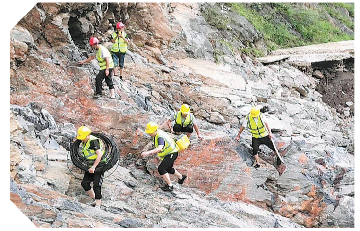
商洛移动在洛南县抢修被水灾损毁的基站
