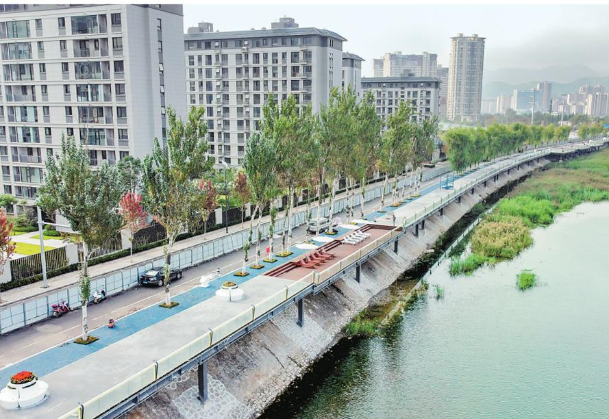
丹江源城市滨水步道是中心市区“2+7”水生态修复的重要项目,位于仙娥湖东路丹江干流左岸,上起二龙山水库坝下,下至起构峪桥,全长1.7公里,估算总投资1.49亿元。修复拓宽人行步道1.7公里,实施河堤加固1.9公里,河道清淤0.89万立方米,实施透水混凝土1.31万平方米,布设沿河护栏1.7公里,设置综合功能服务设施4组及其他附属设施。目前,已安装完成预制管桩521根,修复河堤1.7公里,安装玻璃护栏1200米,主体工程已完成85%。(本报记者 张志宏 摄)
