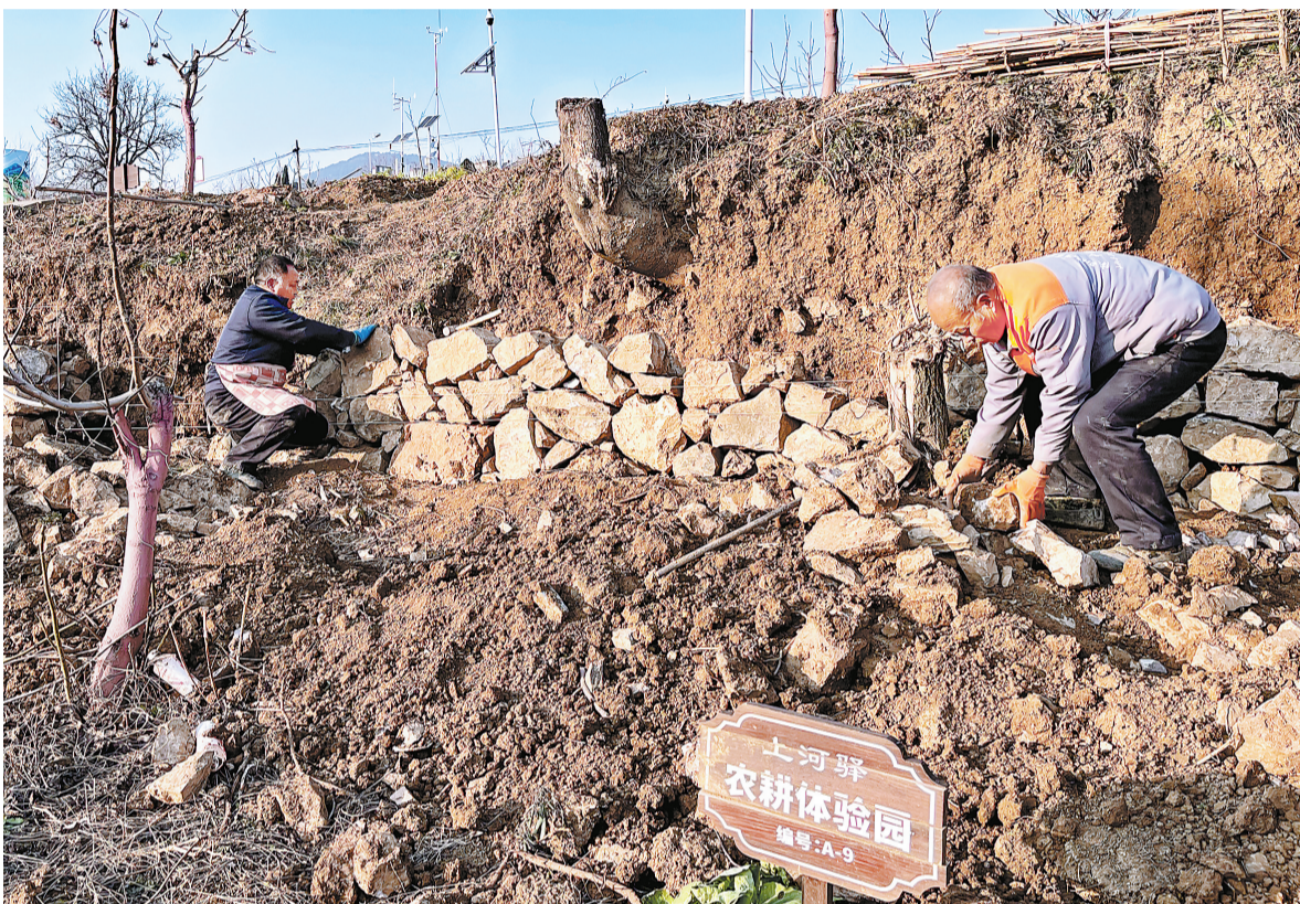
12月19日,商州区陈塬街道上河村的“上河驿”农耕体验园里,村民正在整修园地的护坡。近年来,上河村以打造环境优美、产业兴旺、农旅融合的乡村振兴示范点为目标,不断进行产业优化升级,积极探索林下种植和休闲体验等发展模式,因地制宜走出了一条立体化的可持续发展之路。(本报记者 王倩 摄)
