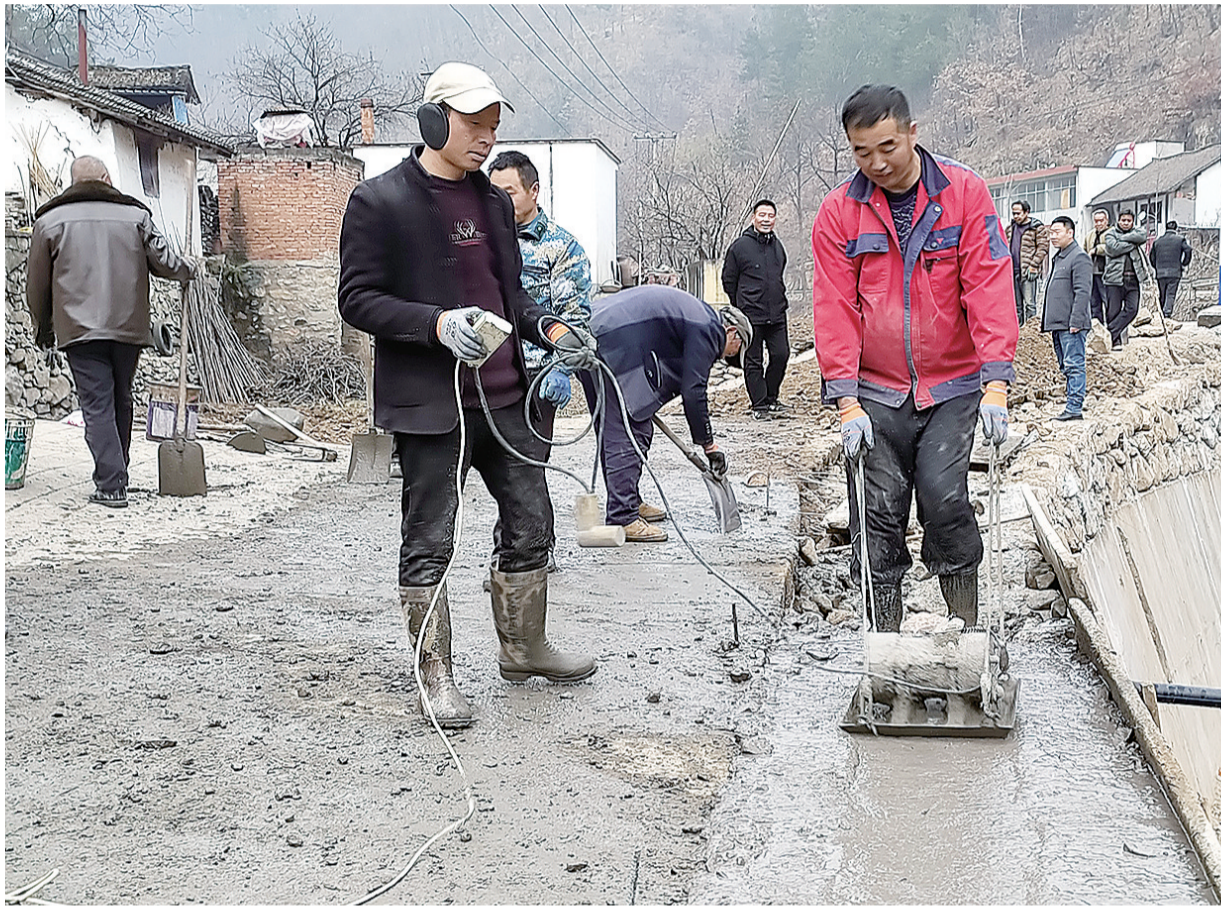
2023年12月29日,丹凤县武关镇枣园村新房组群众在进行通组路硬化施工。据了解,该路段因水灾冲击,多处路面破损严重,影响群众出行,村里组织施工队加高河堤,拓宽硬化路面,确保群众出行安全。(本报记者 贾书章 摄)
