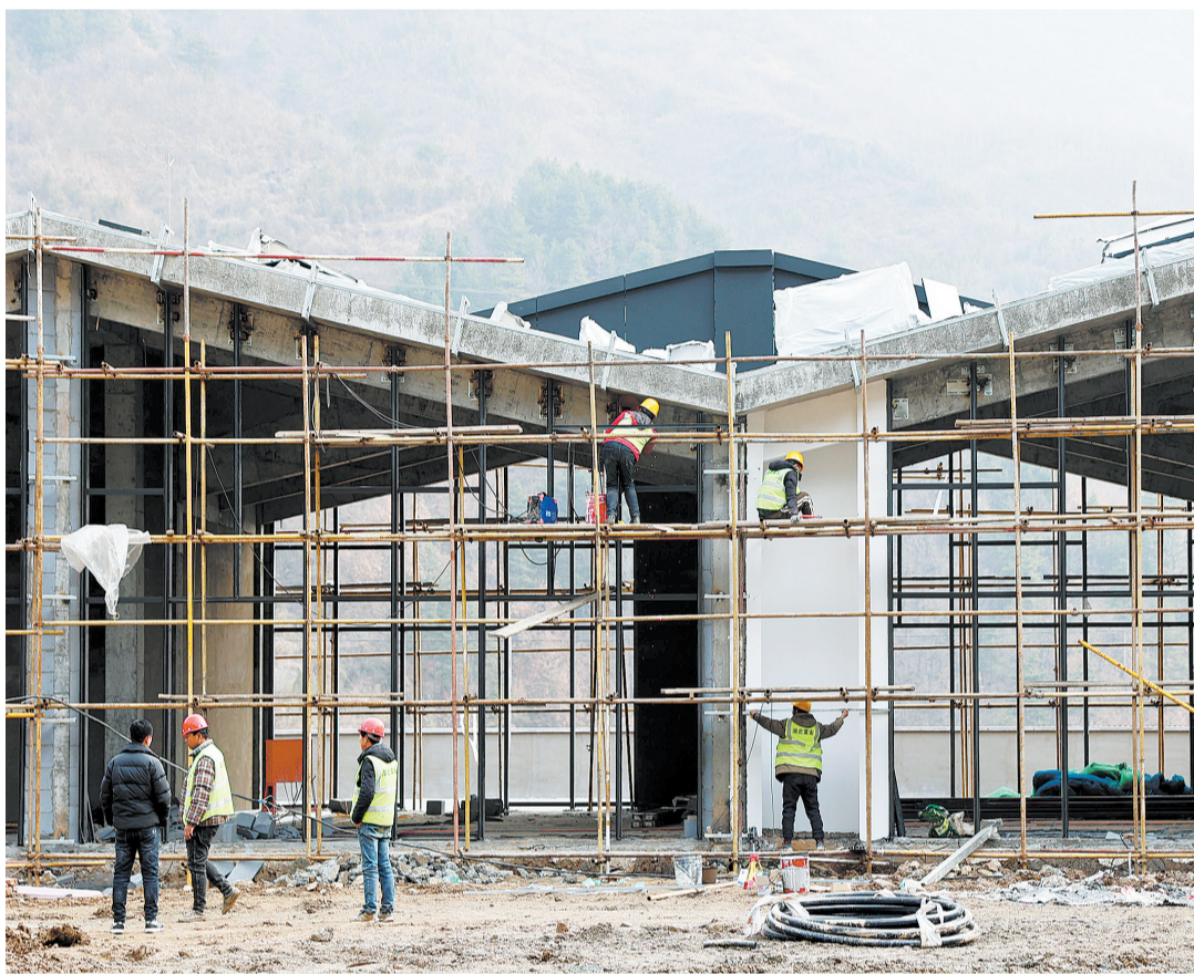
3月16日,山阳县天竺山国家森林公园改造提升项目正紧张施工中。该项目依托天竺山优越的生态格局,整合山上山下一体化开发打造生态康养度假旅游区,计划5月1日预开园接待游客。(本报记者 谢非 摄)
