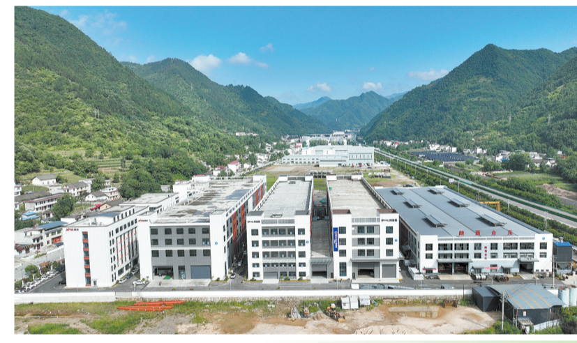
柞水现代装备制造产业园
