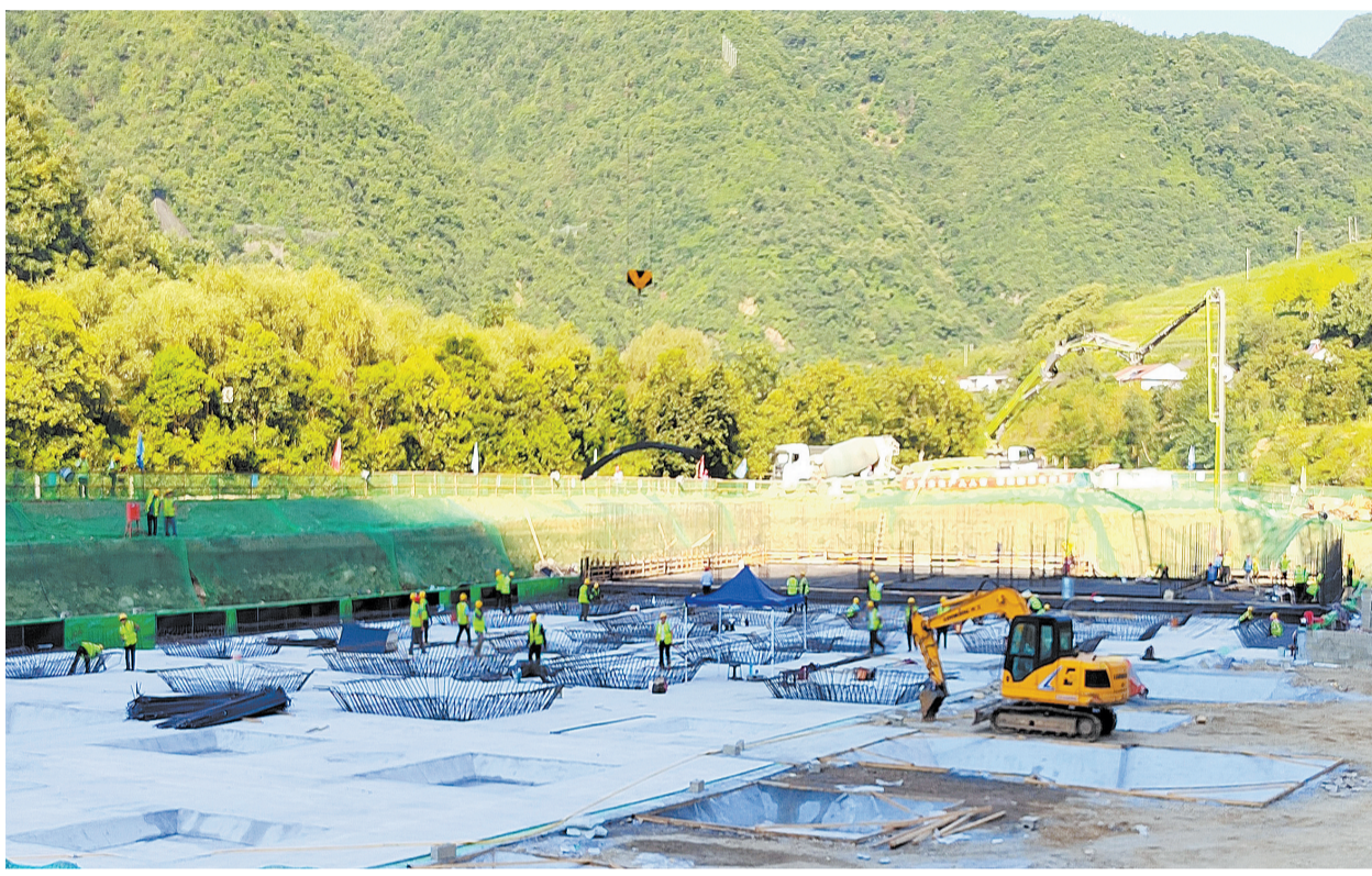
8月15日,位于柞水县什家湾村西部食用菌交流中心(柞水木耳交易中心)项目正在进行基础建设。该项目总投资2亿元,7月底开工,计划2025年建成,该项目旨在打造一个集产业交流、产品交易、商贸展览、综合服务、仓储物流于一体的现代化食用菌交易交流中心。(本报通讯员 康伟桐 摄)
