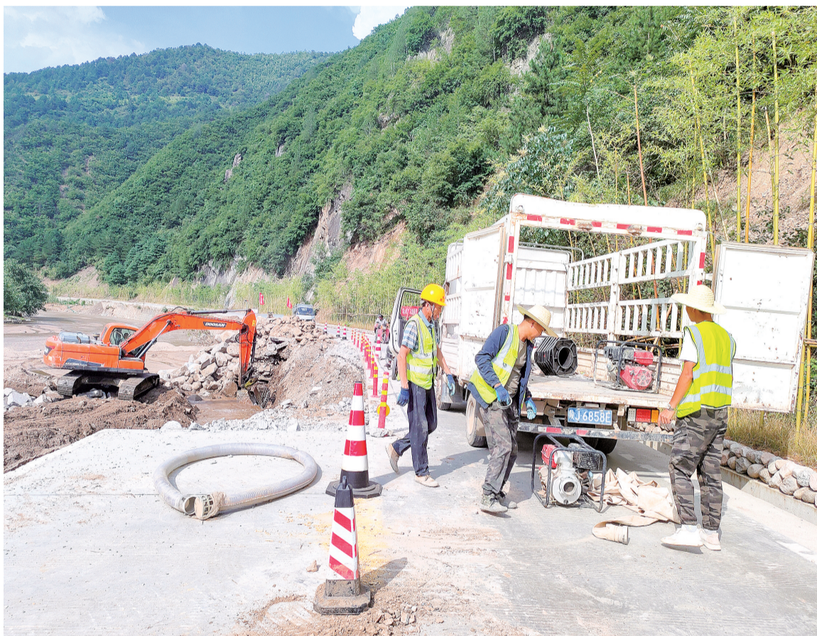
8月17日,柞水县曹坪镇组织交通应急保障队伍对水毁道路进行维修、对路肩及防洪坝进行加固,消除道路安全隐患,全力保障群众出行安全。(本报见习记者 孙远飞 摄)
