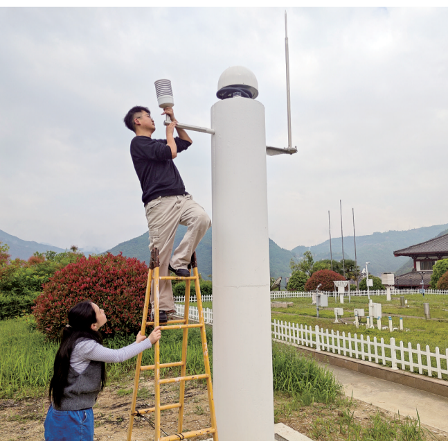
为确保各项气象数据采集准确、传输正常,近日,镇安县气象局业务技术人员深入国家基本气象站开展观测设备技术维护,对设备的供电、采集、传输等系统开展了逐个排查,对已损部件进行了更换。(本报通讯员 程卫红 摄)
