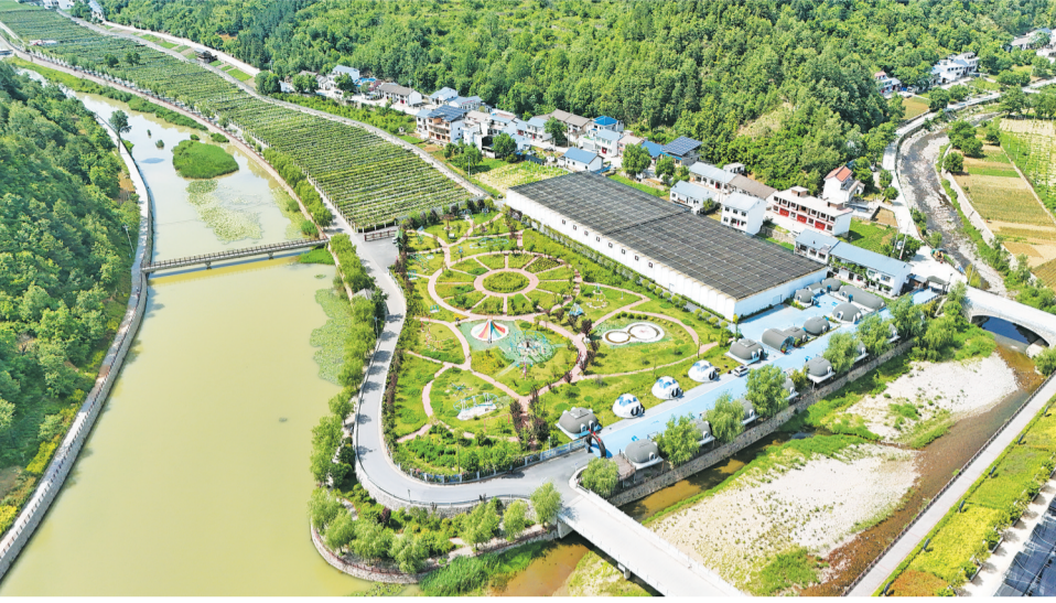
商洛镇天麻产业园新建的12个智能种植车间——智慧方舱。
