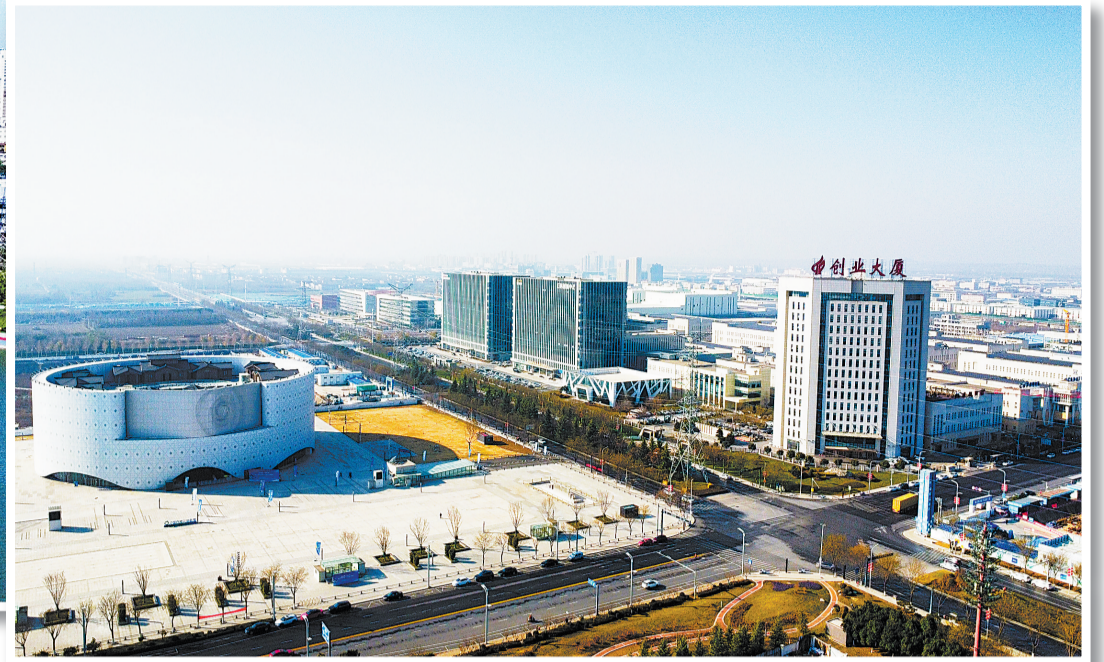
▽航拍视角下的咸阳高新区,创业大厦、中国西部AI创新港、汇科创新中心与各类厂房错落排布,彰显城市产业高质量发展的空间格局与澎湃动能。
