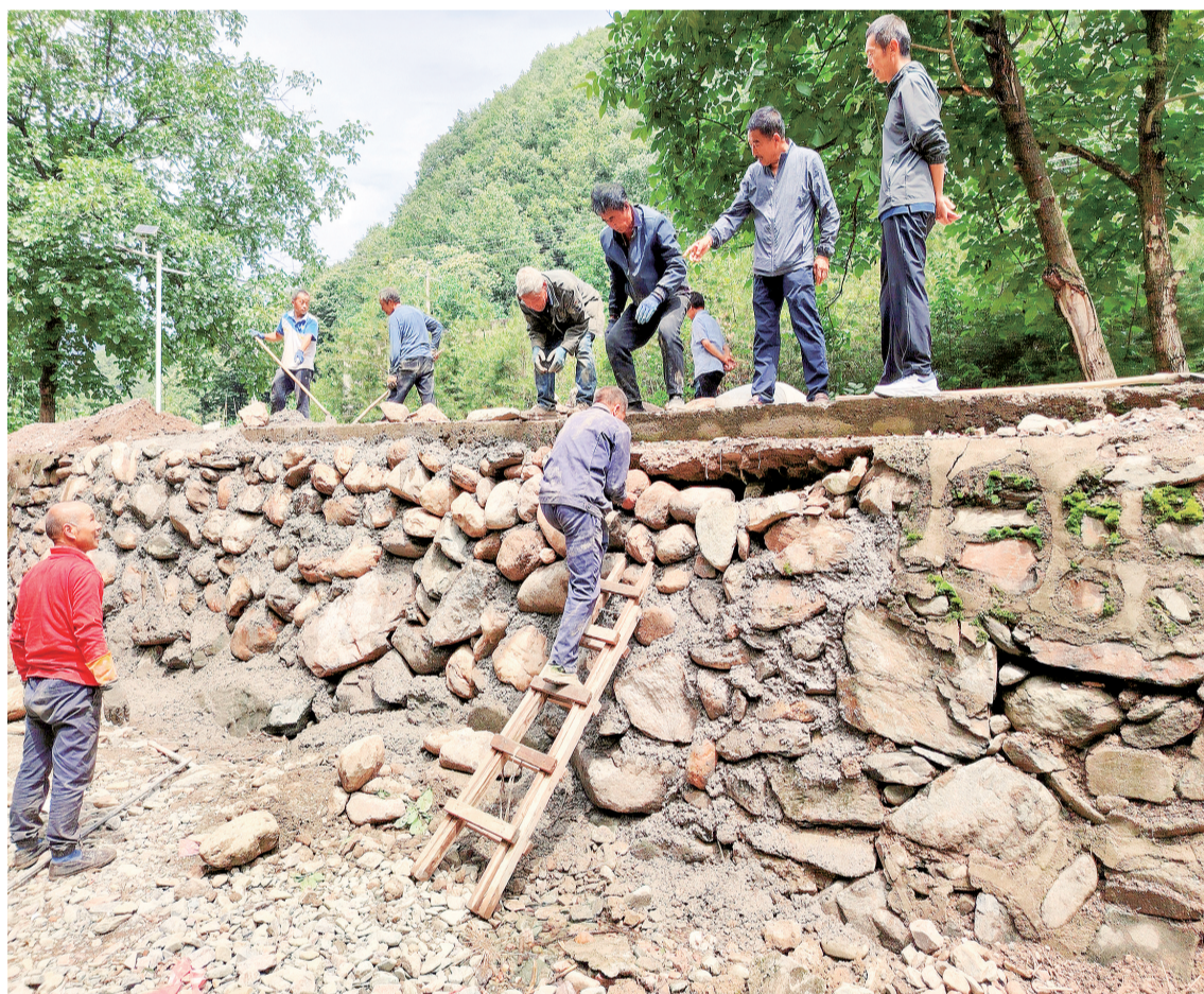
6月24日,洛南县保安镇三义村驻村工作队与村组干部组织指导施工人员进行加固修复水毁道路、险工险段,为当地群众生产生活、安全出行保驾护航,保障防汛避险各项措施落实落细到位。(本报通讯员 杨开让 摄)
