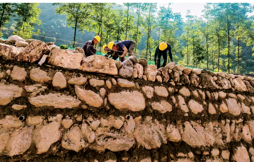
七月七日,在镇安县庙沟镇河道整治现场,挖掘机轰鸣作业,工人忙着清理淤积河段并加固堤坝,提升河道行洪能力,确保汛期安全。(本报通讯员 卢金林 摄)
