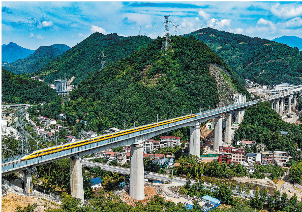
7月10日，西康高铁启动最高测试速度等级提速试验，经多轮逐级提速测试，检测列车当日跑出时速385公里试验目标速度。此次提速试验的成功，标志着线路设备已达到高速运行的条件。图为高速综合检测车行驶在西康高铁镇安西站2号特大桥上。（本报通讯员 倪方海 摄）
