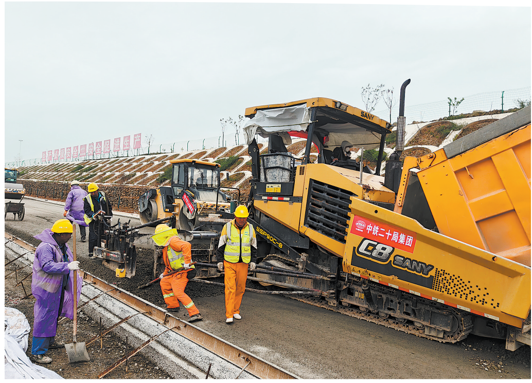
洛卢高速项目施工现场。
