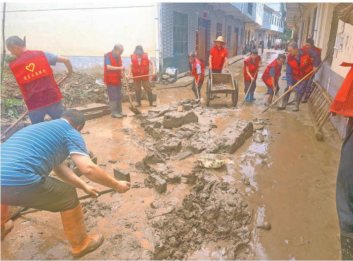
曹坪镇马房湾村村干部组织群众清理淤泥，恢复道路通畅。
