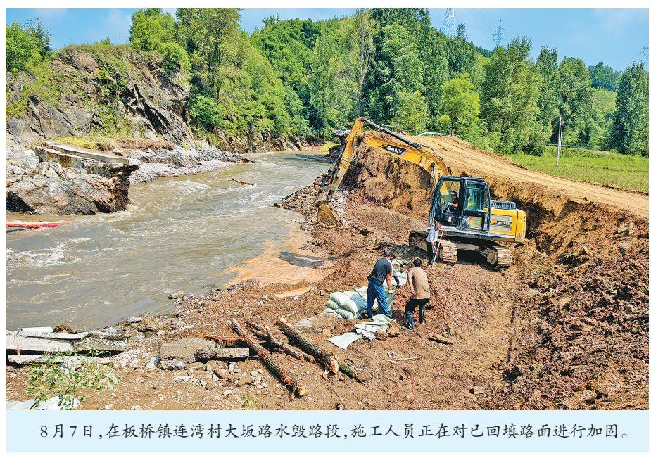
8月7日,在板桥镇连湾村大板路水毁路段,施工人员正在对已回填路面进行加固。
