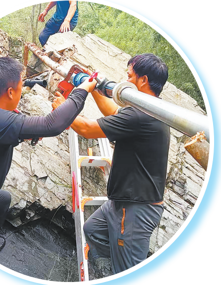
8月8日，过风楼社区村民正在抢修被大雨冲断的水管。
