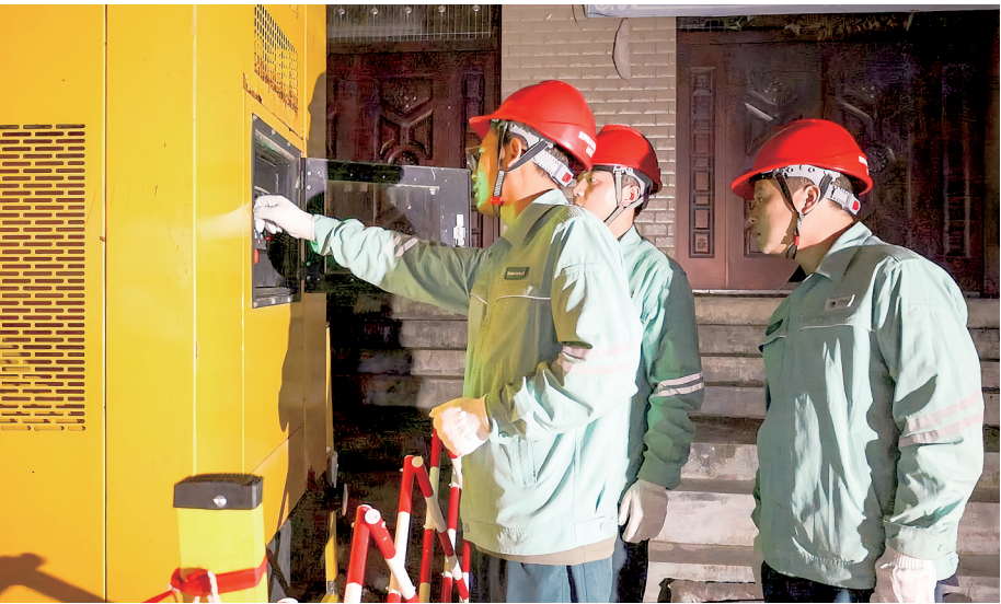
陈龙(左一)和同事为大坪镇街道接入发电机组,为街道提供临时供电。
