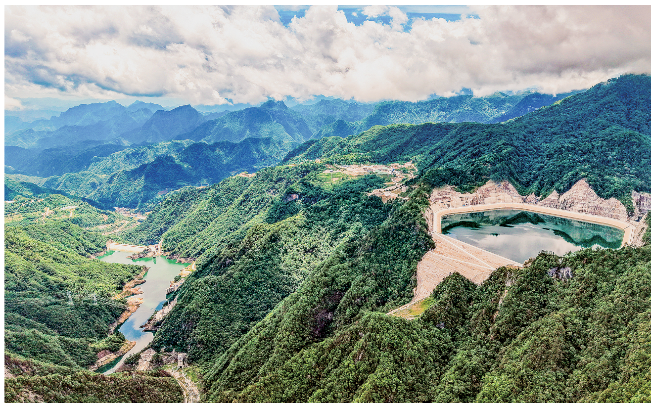
镇安抽水蓄能电站
