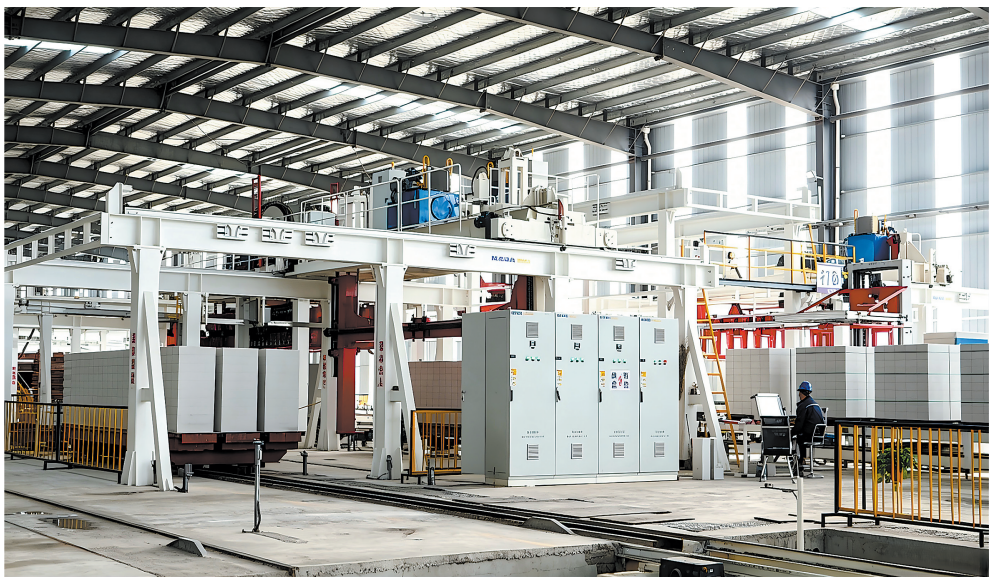
鑫磊恒达尾矿收集预处理和综合回收利用升级改造项目
