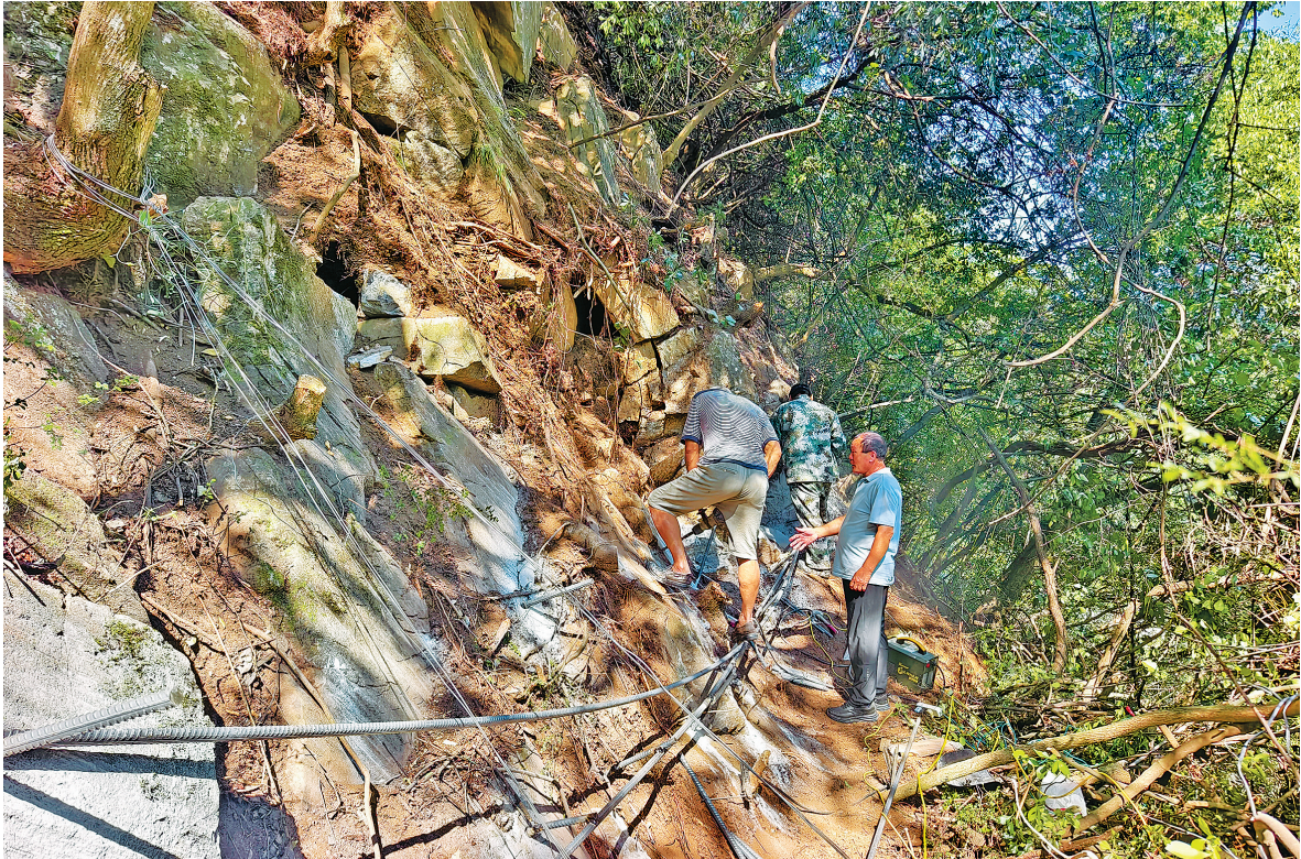
9月1日,山阳县西照川镇郑家庄村干部在日常巡查中发现,部分山石因暴雨松动悬空,危及民宅。镇党委、政府迅速组织千群,使用撬棍和钢钎等工具,在两天内精准排除三处危石,并用焊网加固坡面,消除隐患,确保群众安全。
