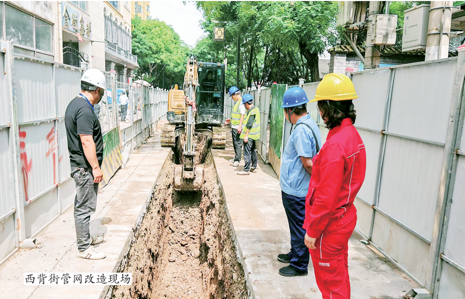
西背街管网改造现场
