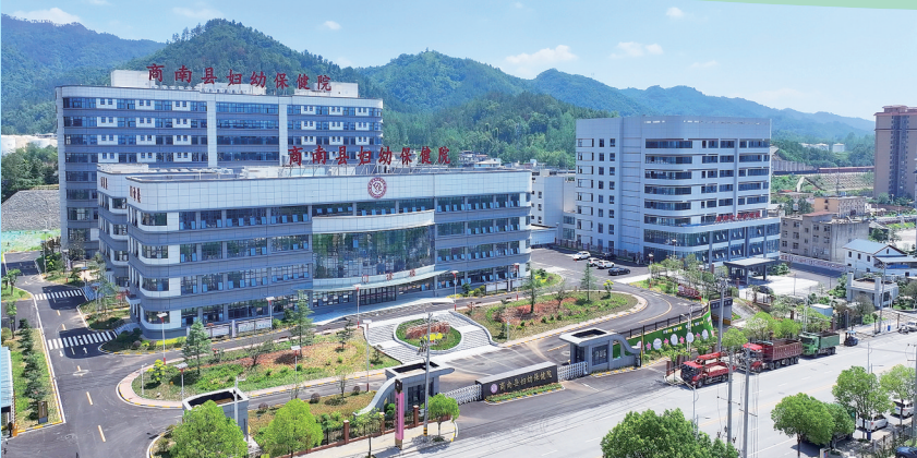
商南县医养产业园
