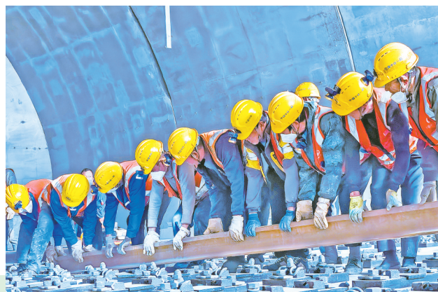
2025年11月1日,柞水马房子隧道内,工人们“拧成一股绳”,实施铺轨作业。
