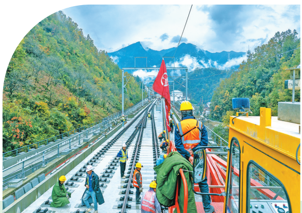
2025年11月7日,镇安西站施工现场,铺轨机械有序就位,工人们分布在轨道之上,全力推进铺轨施工。
