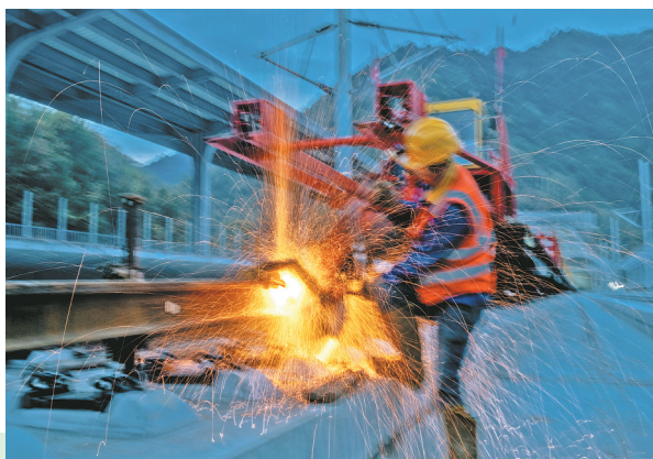
2025年11月1日,工人们在柞水西站进行焊接作业。随着焊接设备启动,钢轨接口迸发出炽烈火光,万千金色焊花肆意飞溅,划破黄昏。
