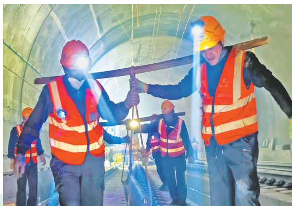
2025年11月1日,柞水县马房子隧道内,建设者们依靠安全帽灯照明,合力抬运施工构件。秦岭隧道地质复杂、作业环境艰苦,很多工序需要人力作业。
