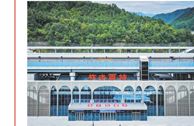
西康高铁柞水西站
