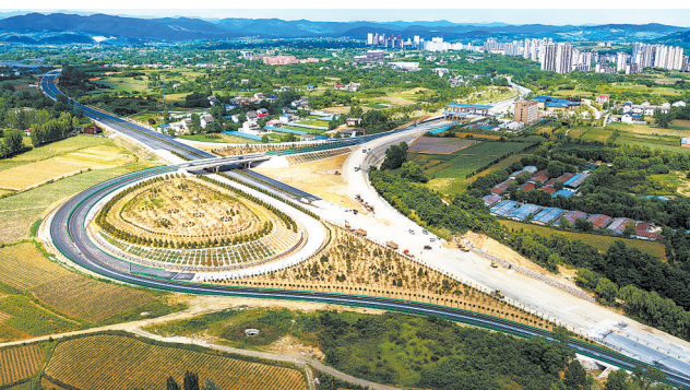
建设中的洛卢高速,是洛南县打通向东出行新通道的重点工程。
