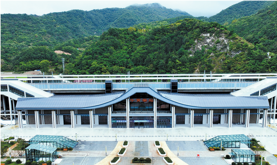
9月18日拍摄的西康高铁牛背梁站(无人机照片)。（新华社记者 韩文涛 摄）
