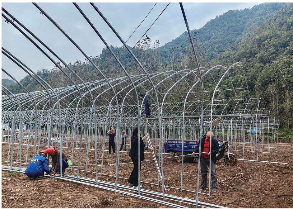
马蹄店村香菇大棚建设现场。
