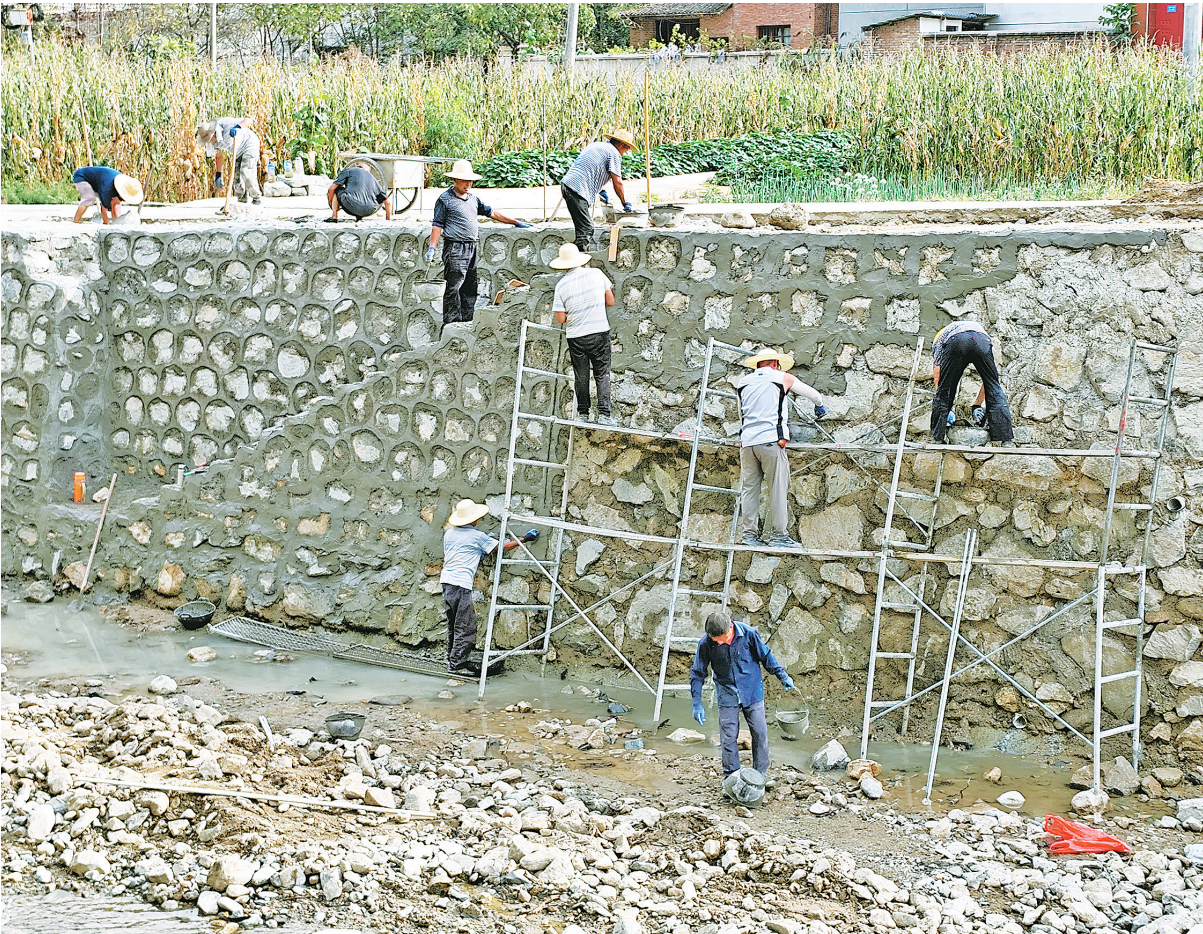
9月29日,雨后初晴,商州区金陵寺镇加快修复水毁路堤,确保农业生产和群众出行安全。图为金陵寺镇刘村灾后修复工程施工现场。
