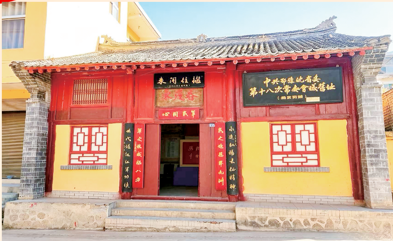
位于丹凤县鹿岭镇的中共鄂豫皖省委第十八次常委会议旧址。
