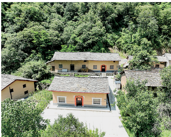
引龙寺村的石板房以土夯墙为围护、木构架为承重、青石板为屋顶，结构稳固、冬暖夏凉，兼具实用性与原生态美感。
